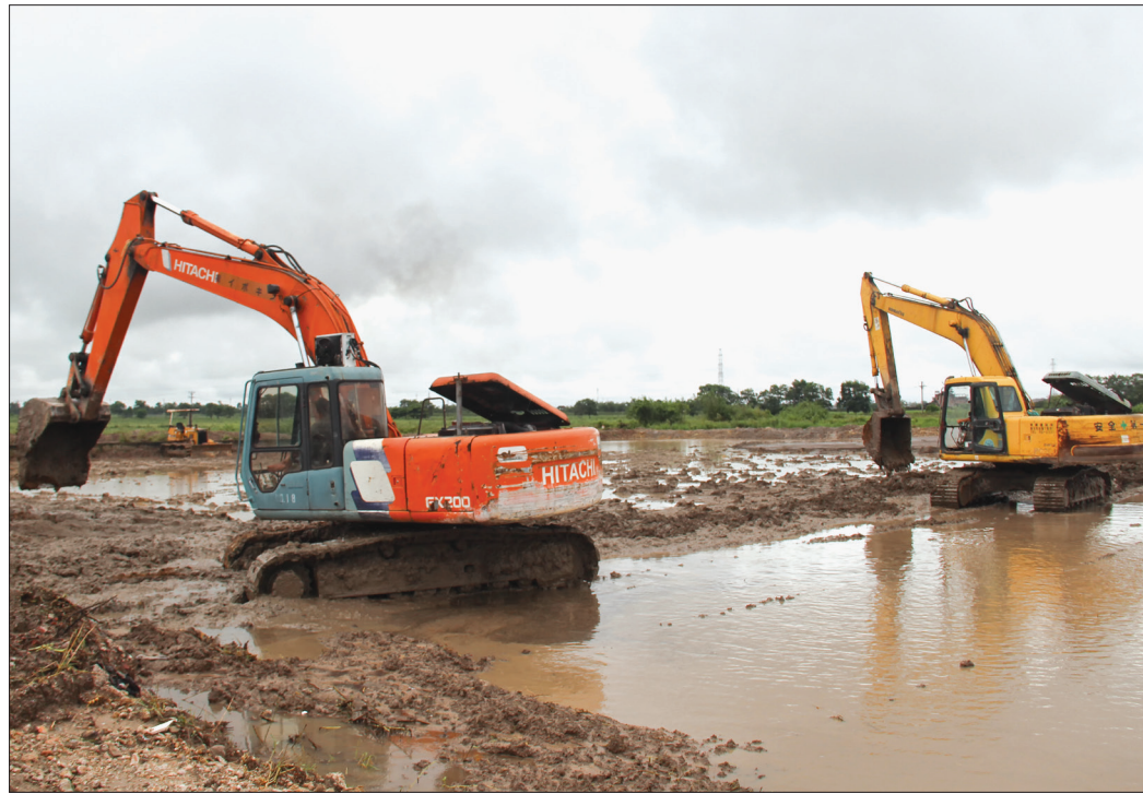
Triển khai dự án khu công nghiệp Thaco - Thái Bình.
