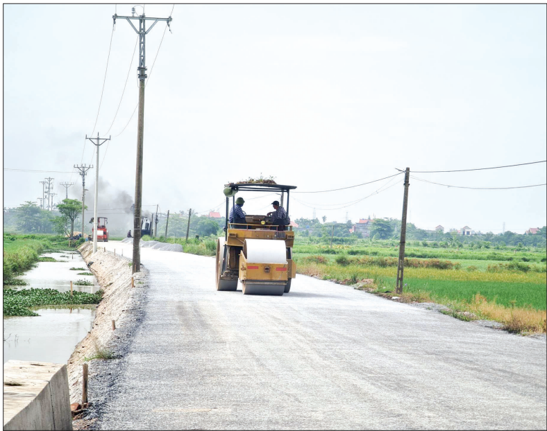
Thi công tuyến đường qua địa bàn xã Quang Lịch.
