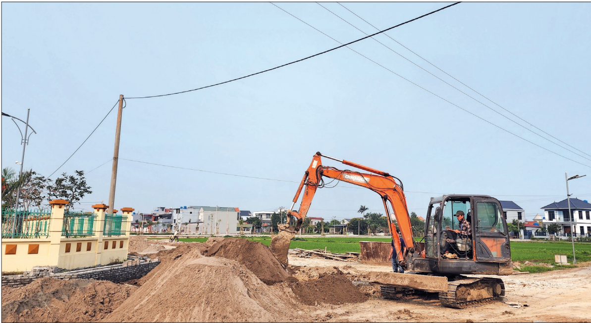
Thi công tuyến đường vào nhà văn hóa xã Đông Xá.
