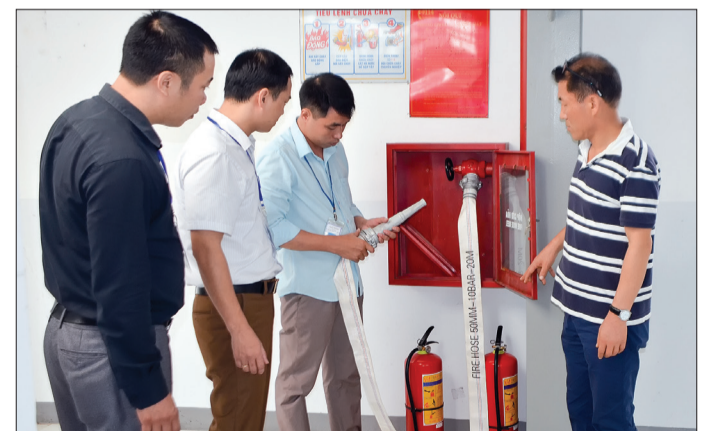
Liên đoàn Lao động huyện Thái Thụy kiểm tra công tác phòng cháy, chữa cháy tại doanh nghiệp.
