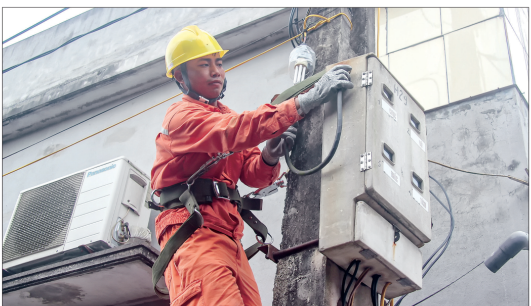
Công nhân Điện lực Đông Hưng kiểm tra lưới điện hạ áp nông thôn.
