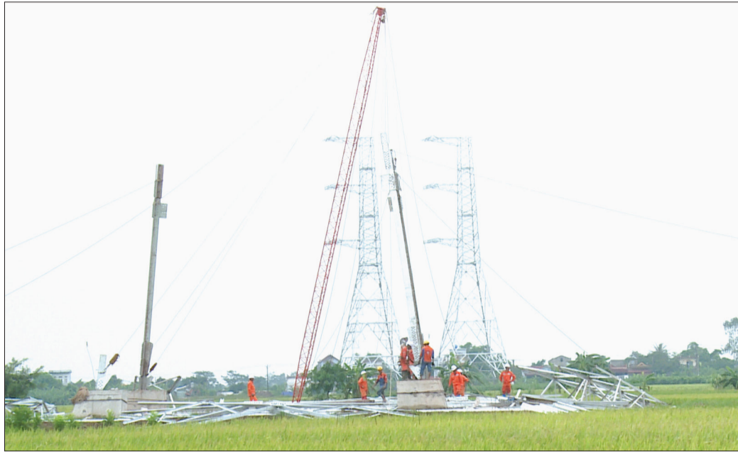
Cán bộ, công nhân ngành điện “vượt nắng, thắng mưa”, quyết tâm đưa dự án về đích đúng tiến độ.
