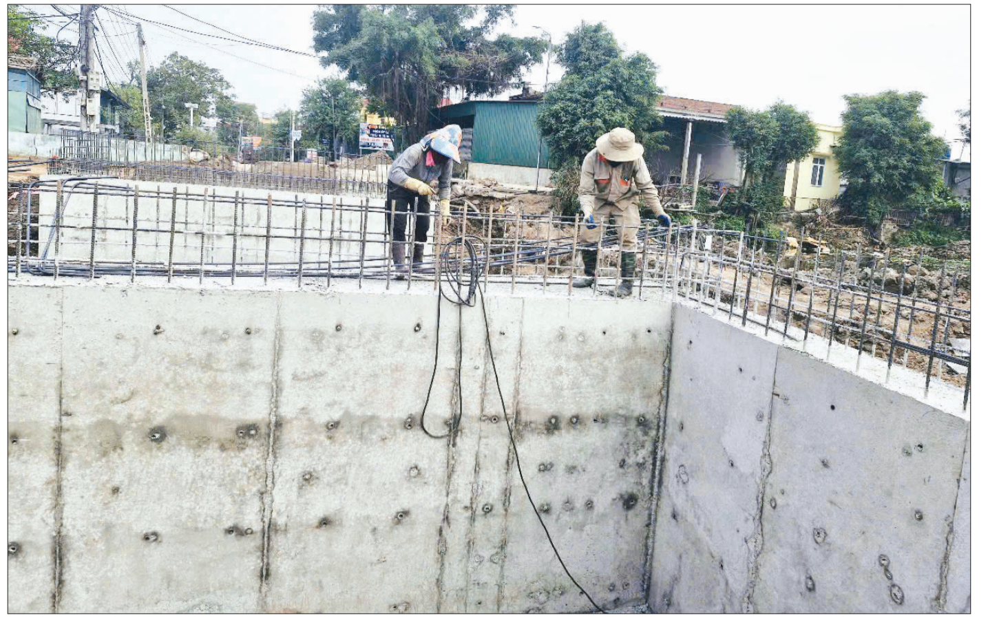
Thi công dự án đường nối từ đường tỉnh ĐT.452 qua xã Duyên Hải (Hưng Hà) đi xã Châu Sơn (Quỳnh Phụ).
