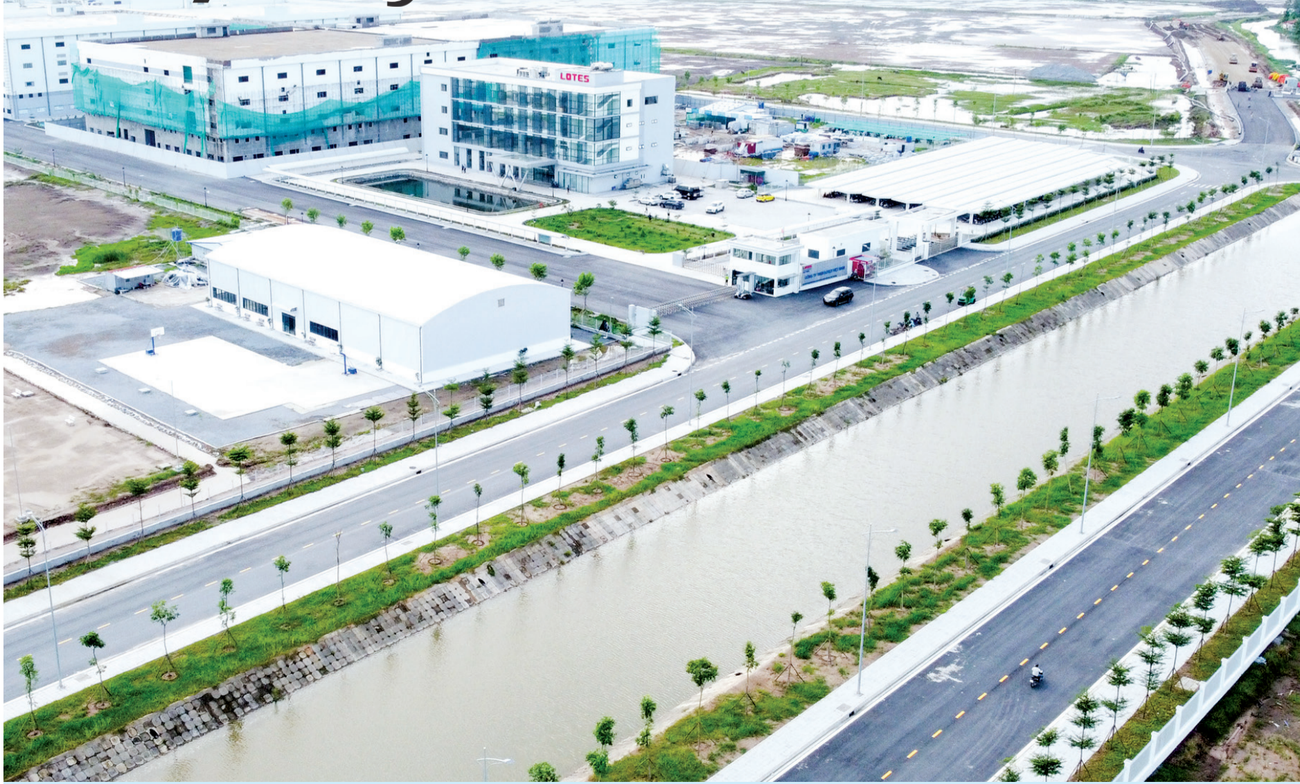
Hệ thống cây xanh và cáp, thoát nước tạo cảnh quan và môi trường khu công nghiệp Liên Hà Thái luôn xanh, sạch, đẹp.
