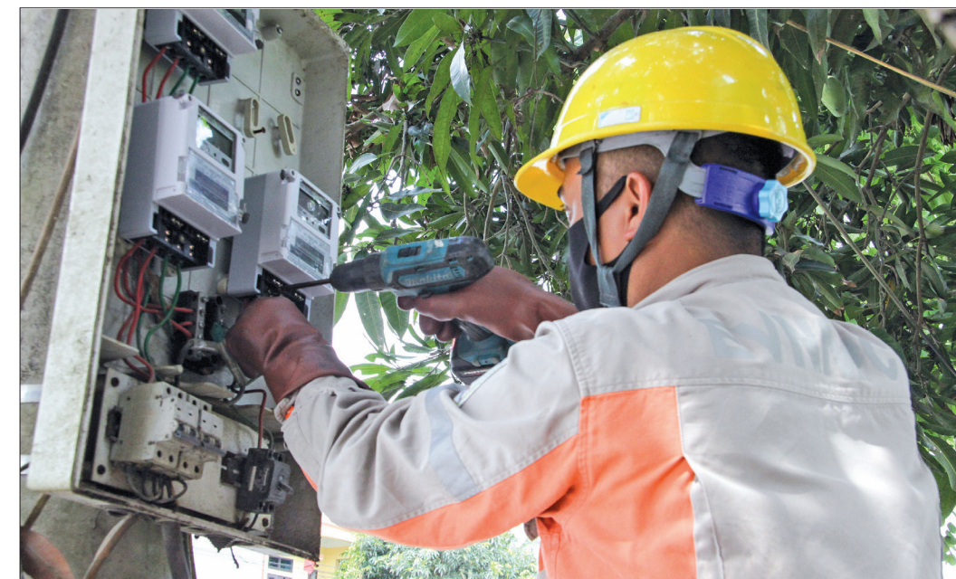
Công nhân Điện lực Kiến Xương lắp đặt công tơ điện tử đo xa cho khách hàng.
