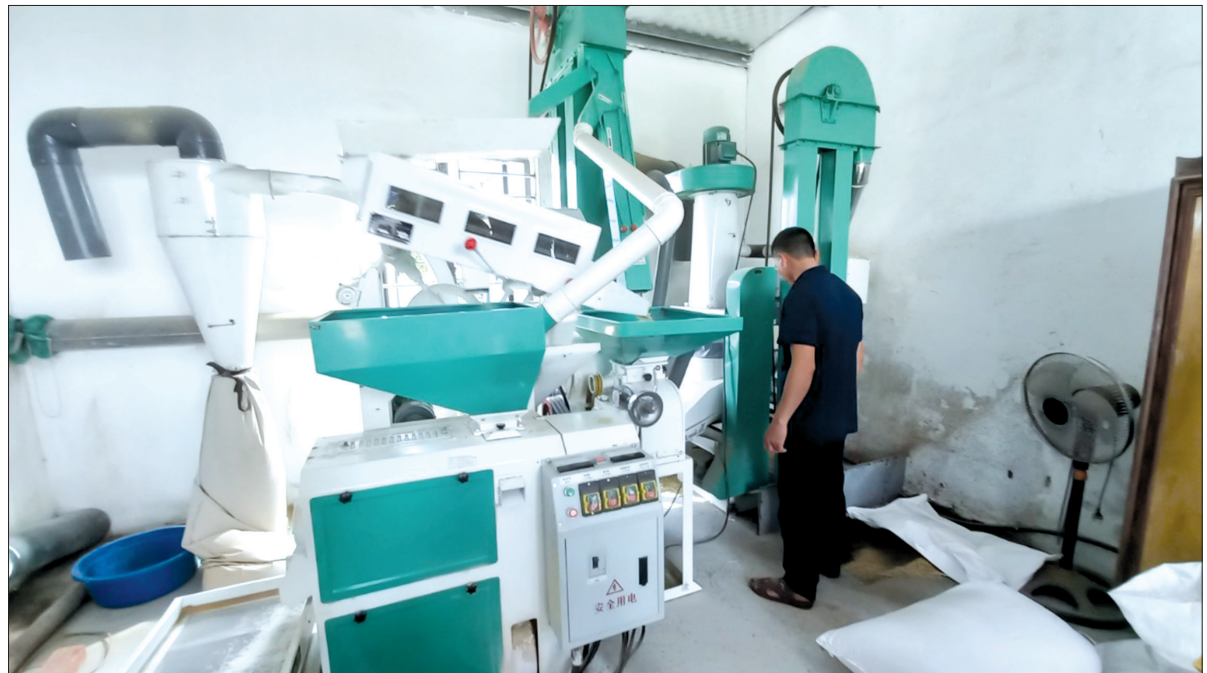
Khu xay xát, chế biến thóc gạo của HTX Thương mại, dịch vụ và kinh doanh lúa gạo Bình Thanh (Kiến Xương) - 1 trong 9 HTX thành lập mới được mô hình hỗ trợ.
