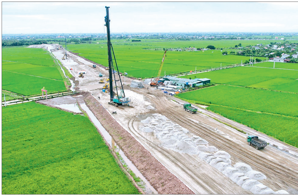
Thi công tuyến số 3, thuộc tuyến đường trực kết nối Khu kinh tế tại huyện Tiên Hải.
