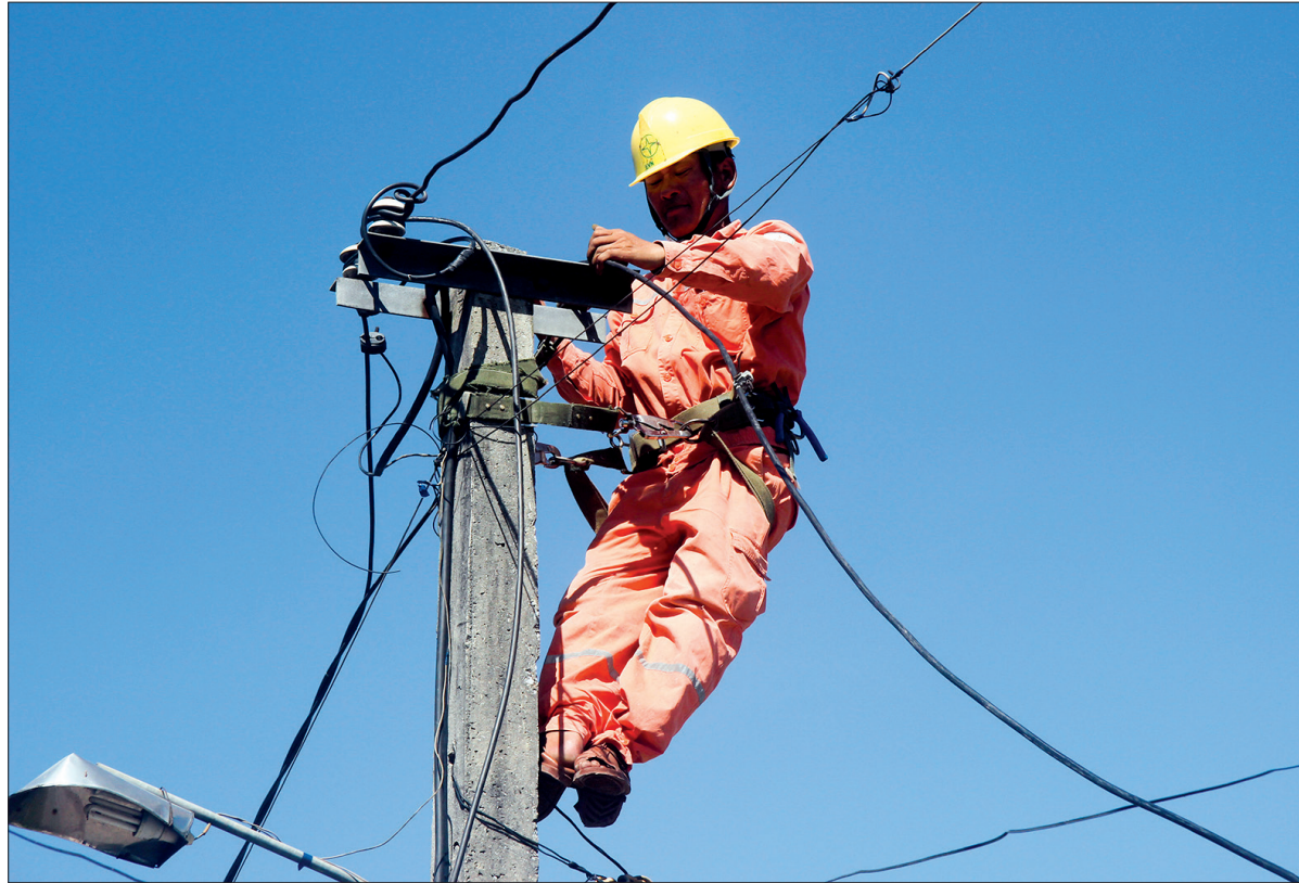
Sửa chữa lưới điện hạ áp nông thôn.
