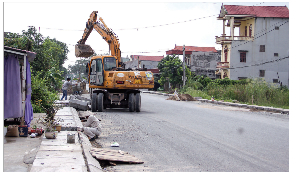
Nhà thầu thi công bố vỉa đoạn qua địa phận xã Phúc Khánh (Hưng Hà).
