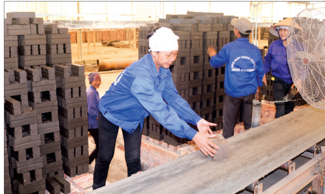
Dây chuyền băng tải tự động giúp công nhân Công ty TNHH Vật liệu xây dựng hạ tầng Hoa Cương giảm sức lao động nặng nhọc.
