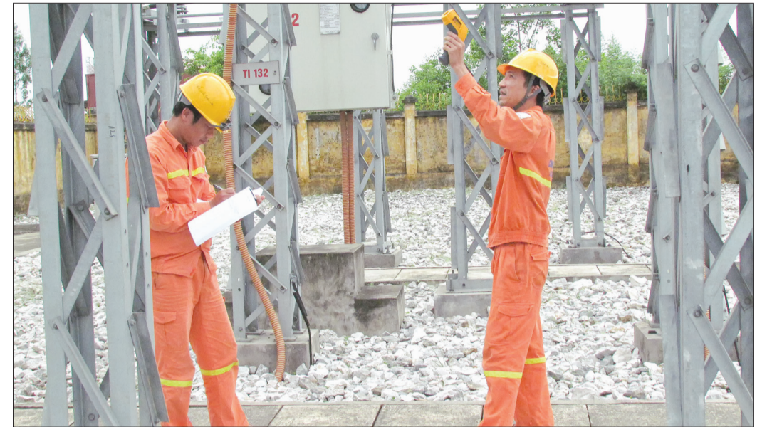
Nhân viên trạm 110kV E11.4 Hưng Hà kiểm tra sự phát nhiệt của các thiết bị điện.
