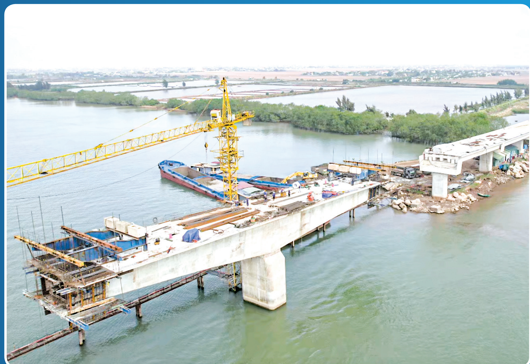
Thi công cầu sông Hồng thuộc dự án tuyến đường bộ ven biển tỉnh Thái Bình.
