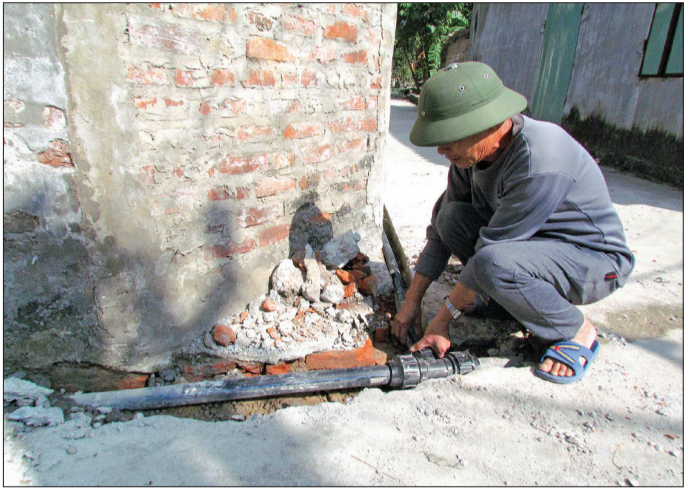
Lắp đặt ống, đường ống cấp nước đến hộ dân xã Phúc Khánh (Hưng Hà).
