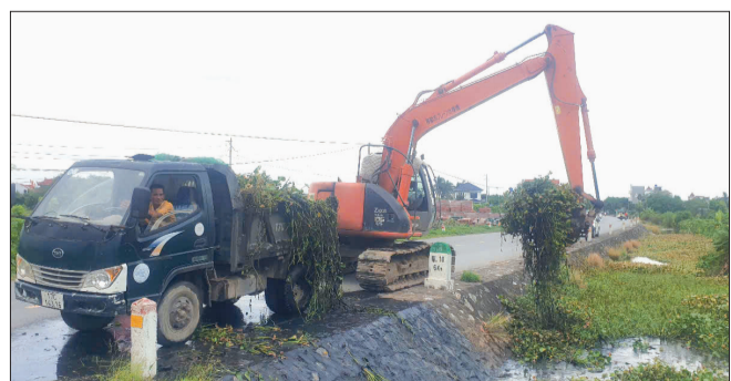
Xã Quỳnh Hội (Quỳnh Phụ) huy động máy móc nạo vét kênh mương phục vụ tưới, tiêu.
