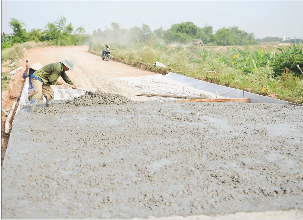
Đoạn đê tả Trà Lý, địa phận xã Bạch Đằng được đầu tư cứng hóa mặt đê.
