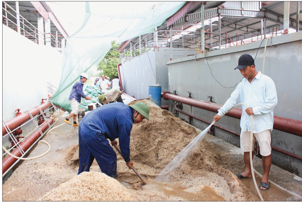
Nhà máy nước sạch Thành Thụy tiến hành thay cát lọc trong bể xử lý nước sạch.
