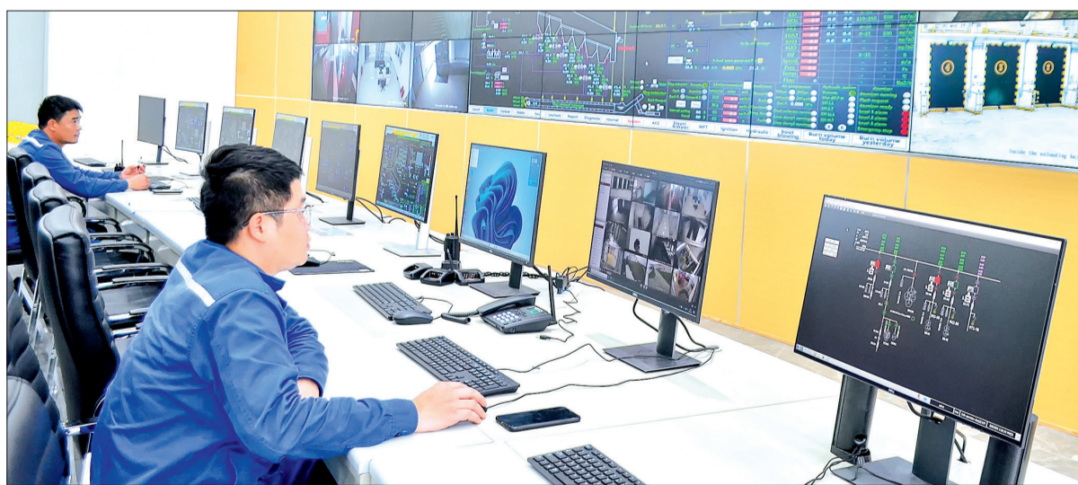
Nhà máy đốt rác phát điện huyện Lương Tài, tỉnh Bắc Ninh được đầu tư công nghệ hiện đại.
