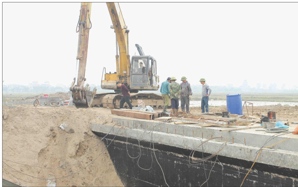
Thi công dự án tuyến đường vành đai phía Nam thành phố Thái Bình.
