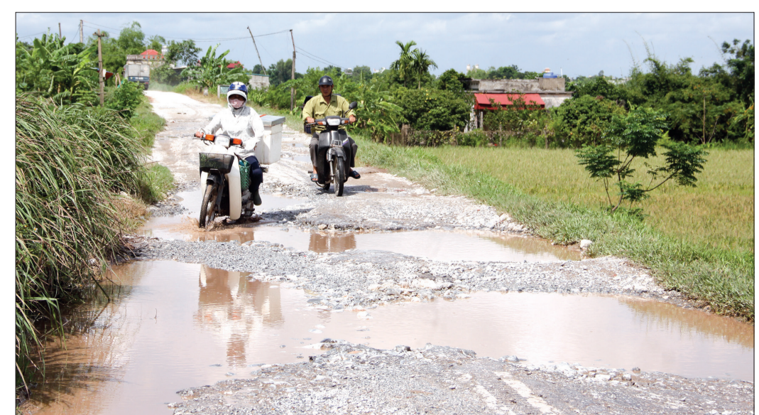
Mặt đê tả Hồng Hà II, đoạn qua địa phận các xã Vũ Đoài, Việt Thuận, Vũ Văn xuống cấp nghiêm trọng gây khó khăn cho người và phương tiện tham gia giao thông.
