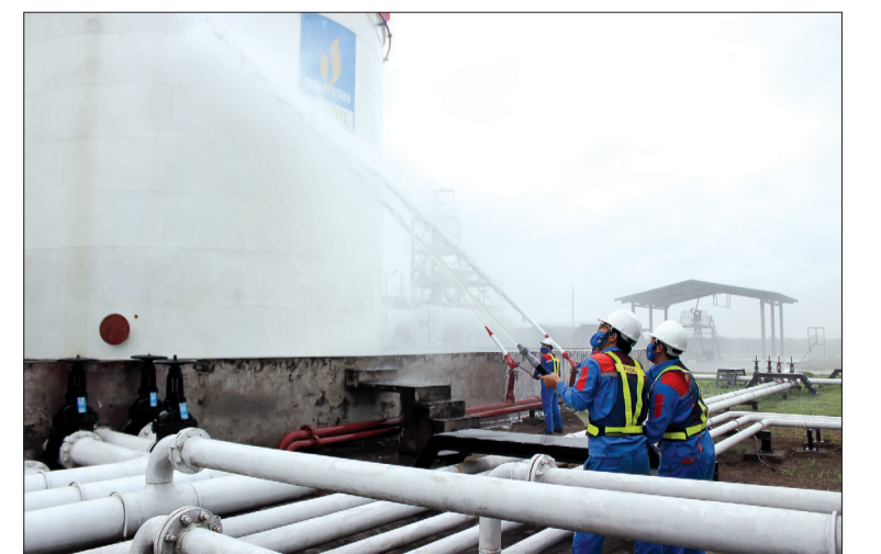
Thực hành phương án chữa cháy tại bốn chữa xăng.
