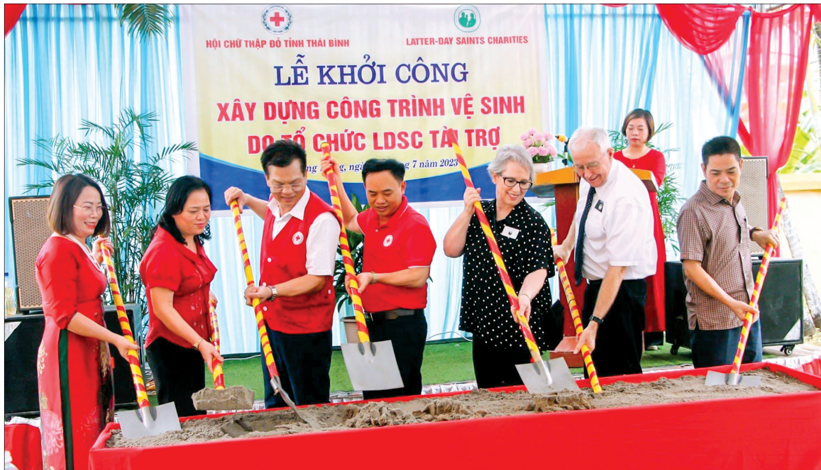
Khởi công xây dựng công trình vệ sinh tại Trường Tiểu học Đông Phong (Đông Hưng).
