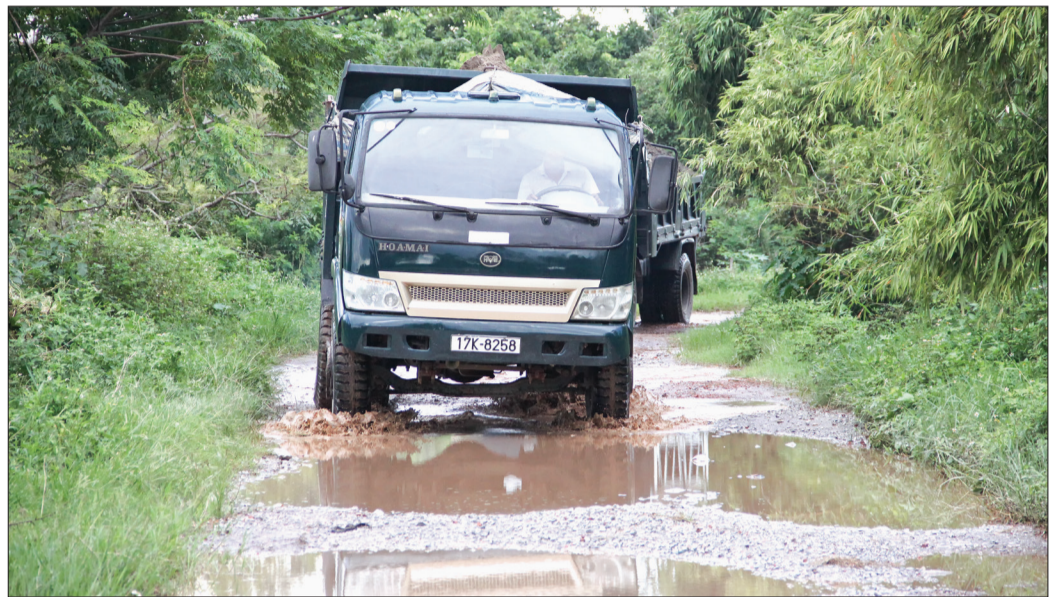
Đề tá Hồng Hà II đoạn qua địa phận xã Vũ Bình (Kiến Xương) xuống cấp nghiêm trọng do xe chở vật liệu xây dựng thường xuyên hoạt động.
