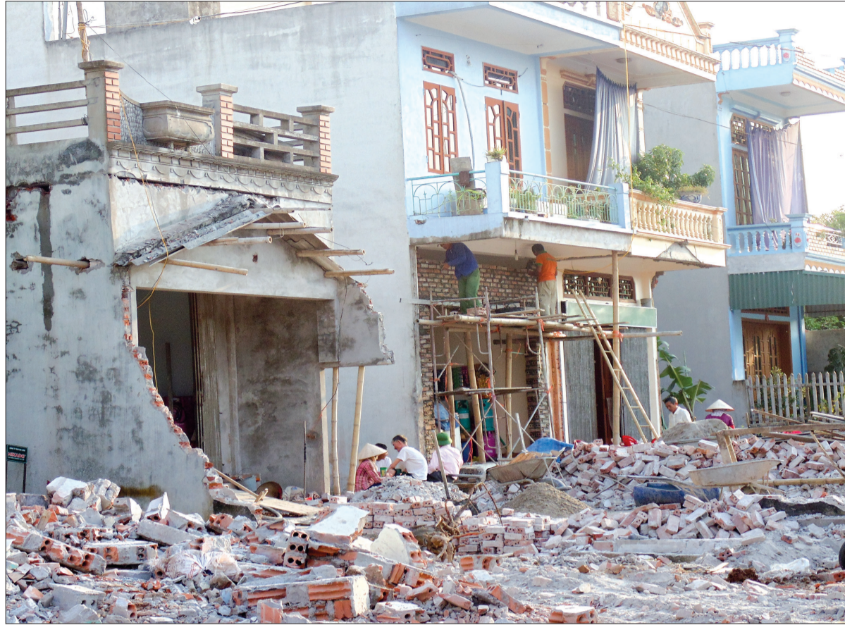
Công tác giải phóng mặt bằng được chính quyền và người dân thành phố phối hợp thực hiện.
