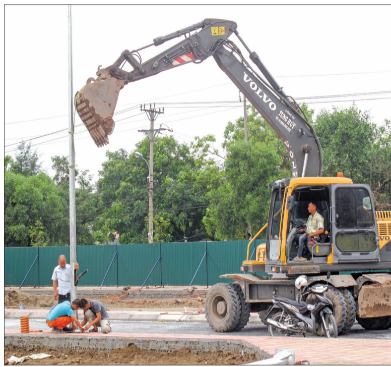
Hạ tầng khu nhà ở thương mại Trường Trung cấp Mầm non đã hoàn thành.
