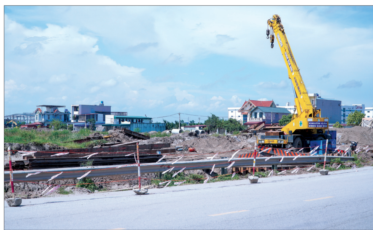
Còn một số hộ dân, doanh nghiệp chưa thực hiện công tác giải phóng mặt bằng làm chậm tiến độ triển khai các dự án khu công nghiệp và đường trục của Khu kinh tế Thái Bình.
