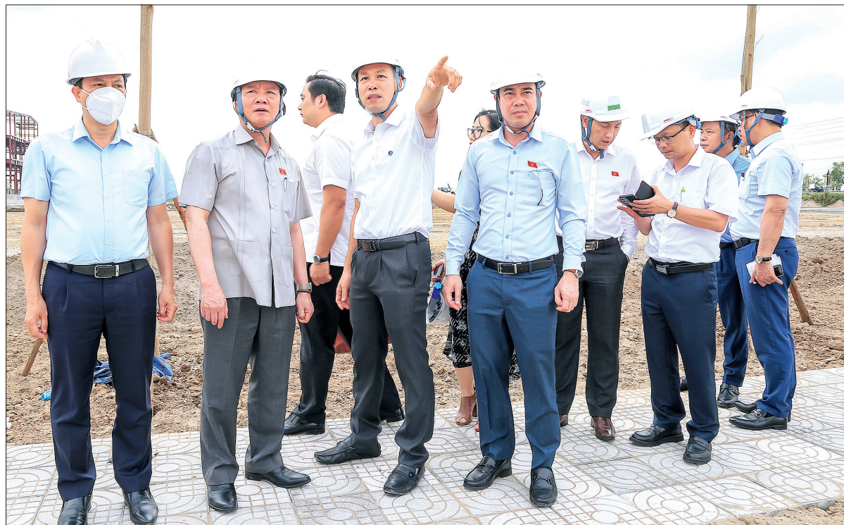
Đoàn đại biểu Quốc hội tỉnh khảo sát tiến độ triển khai xây dựng khu công nghiệp Liên Hà Thái.
