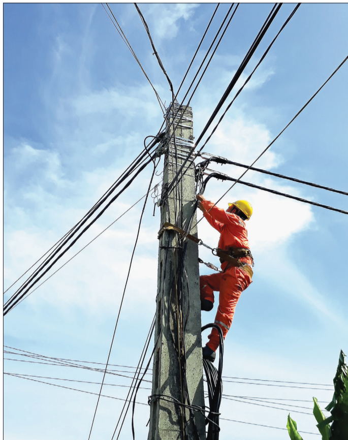
Nhân viên Điện lực Hưng Hà kiểm tra, sửa chữa đường dây.
