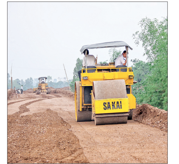
Một số công trình phục vụ công tác phòng, chống lụt, bão trên tuyến đê hữu Trà Lý, đoạn qua địa phận xã Hiệp Hòa (Vũ Thư) đã hoàn thành và đưa vào sử dụng.
