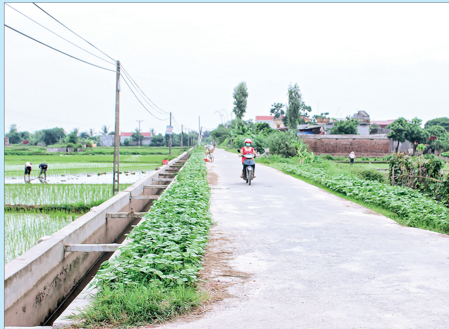
Đoạn đường tại thôn Đông, xã Đông Đô (Hưng Hà) được cứng hóa theo tiêu chí nông thôn mới.
