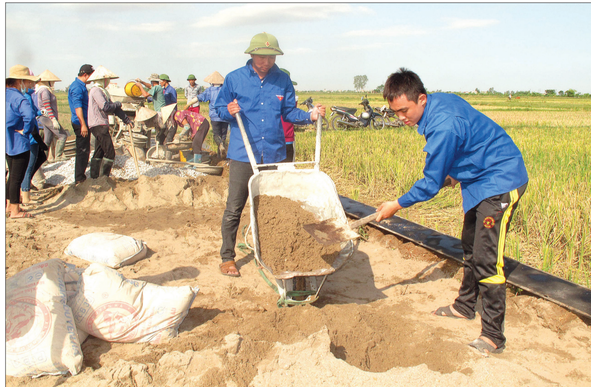
Xây dựng nông thôn mới tại xã Thụy Phong (Thái Thụy).
