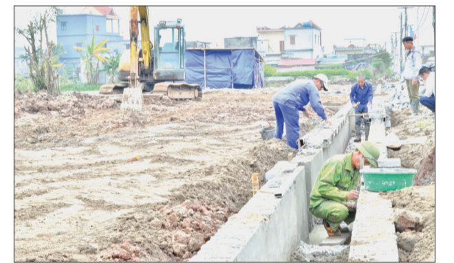
Đẩy nhanh tiến độ hoàn thành hạ tầng kỹ thuật các khu đất đầu giá.
