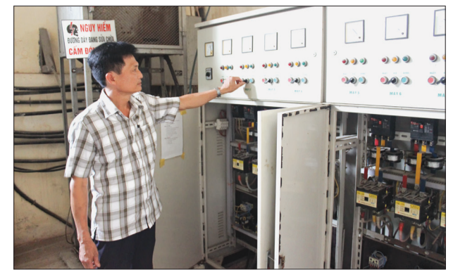
Công nhân trạm bơm Thống Nhất (Tiên Hải) kiểm tra hệ thống máy bơm sẵn sàng phục vụ sản xuất vụ mùa.
