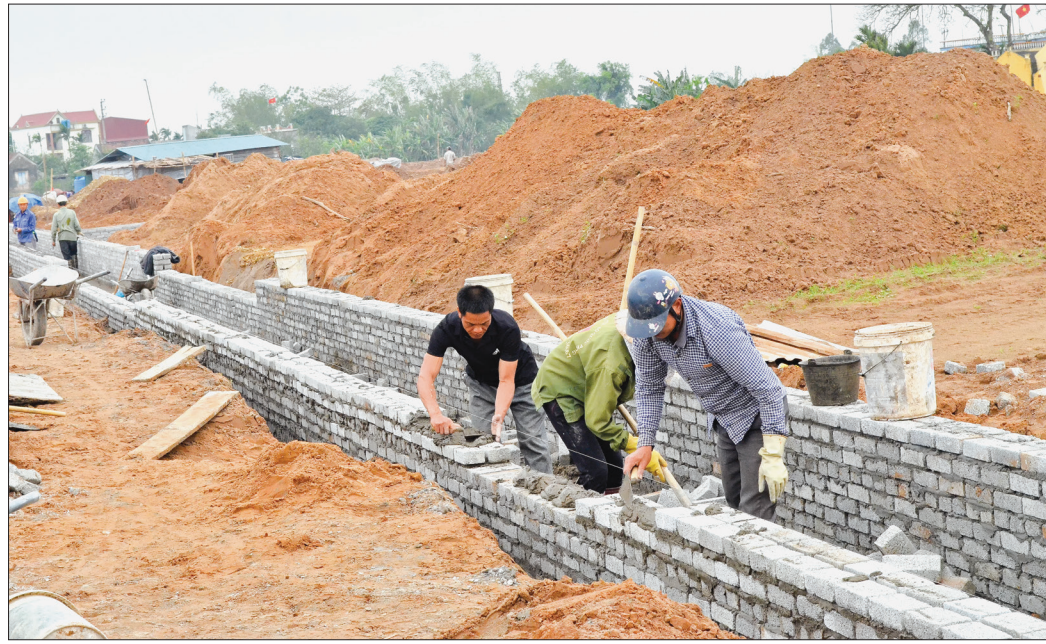
Xây dựng hạ tầng khu tái định cư xã Thái Thượng (Thái Thụy).
