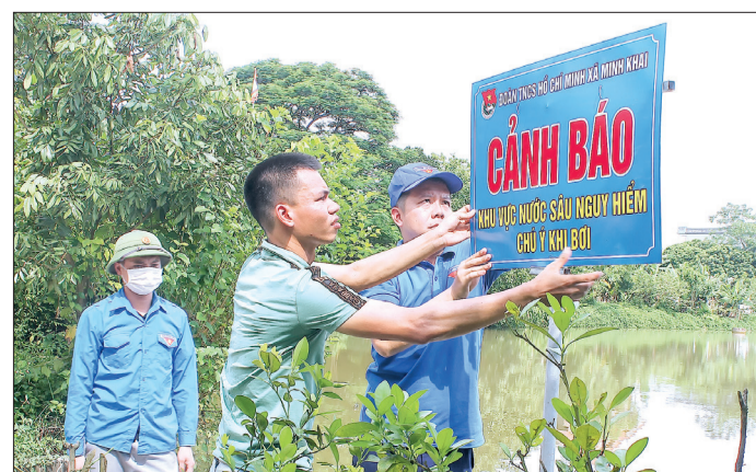
Đoàn Thanh niên xã Minh Khai lắp đặt biển cảnh báo tại khu vực ao Chùa, thôn Thọ Lộc nhằm giúp người dân và trẻ em cảnh giác, để phòng tai nạn đuối nước.
