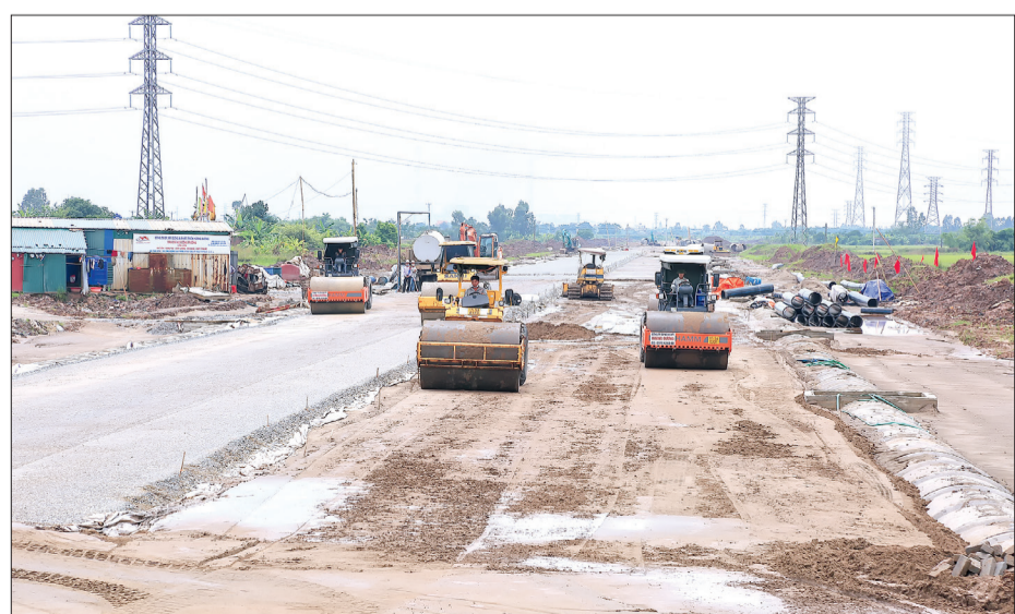
Thi công hạ tầng khu công nghiệp Liên Hà Thái.
