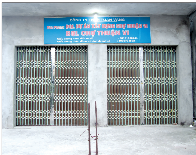
Công trình nhà mái bằng diện tích 120m 2 được Công ty TNHH Tuấn Vang xây dựng năm 2013 không có trong bản vẽ quy hoạch.
