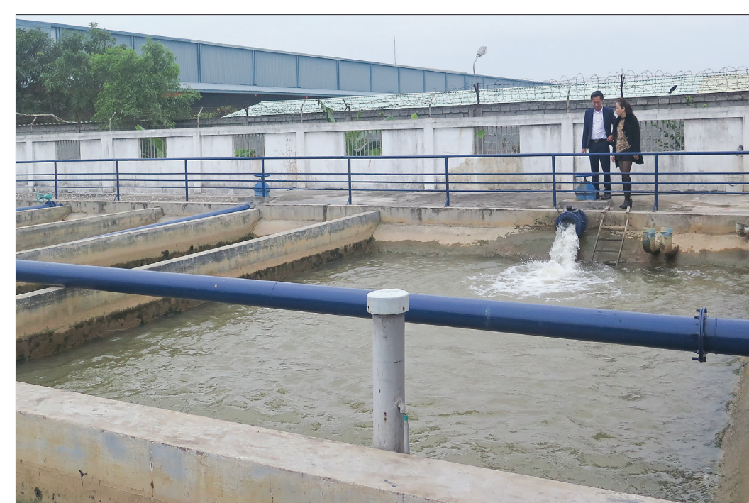
Nhà máy nước Thủy Long.
