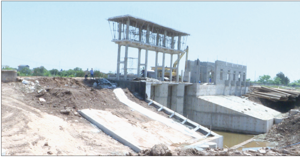
Các hạng mục chính của công trình cống Tám Cửa (huyện Tiền Hải) đã hoàn thành, bảo đảm an toàn phòng, chống lũ, bão.
