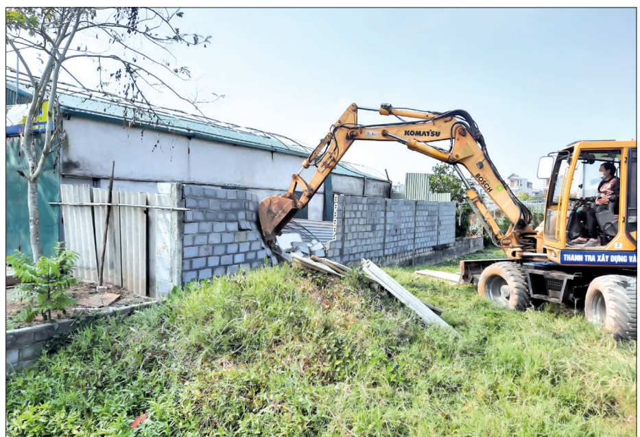
Xã Vũ Chính phối hợp với các đơn vị của thành phố tháo dỡ công trình xây dựng vi phạm trên đất nông nghiệp.
