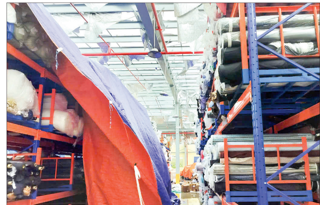
Kho nguyên liệu của Công ty Cổ phần Đô Lương bị bão số 3 làm tốc mái.
