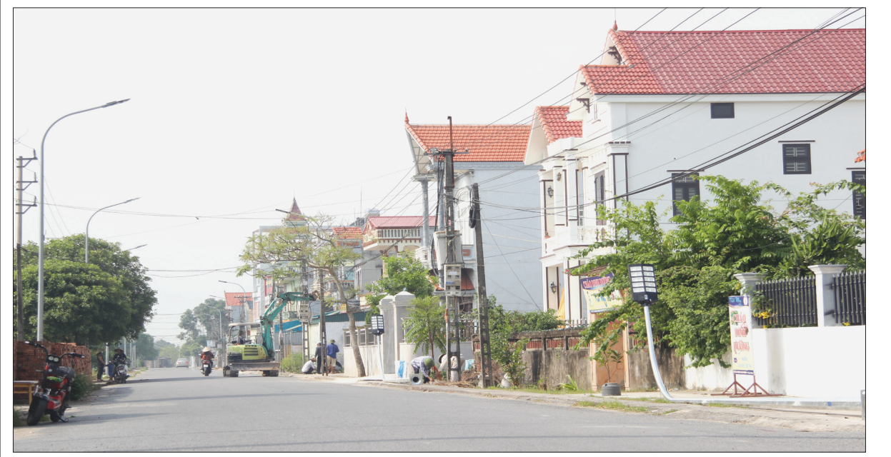
Hệ thống giao thông xã Văn Trường được nâng cấp đáp ứng tiêu chí xây dựng nông thôn mới nâng cao.
