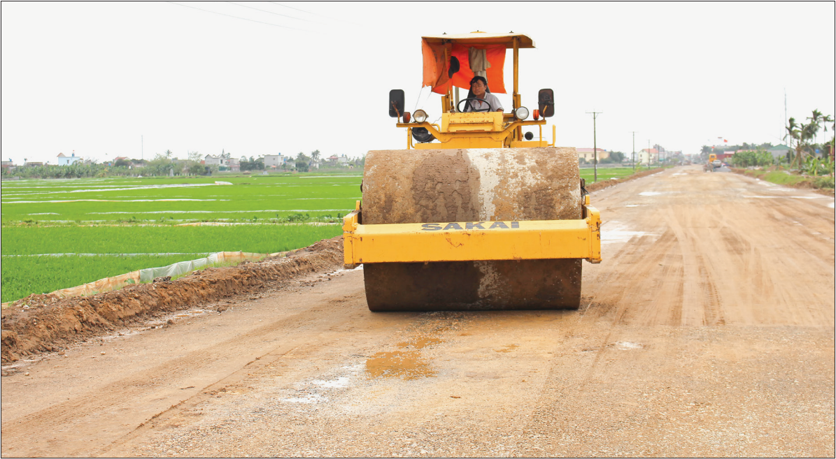
Thi công đường ĐH.91 qua địa phận xã Thái Dương (Thái Thụy).
