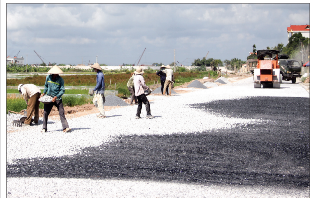
Thi công đường DH.51 đoạn qua địa phận xã Đông Quang (Đông Hưng).
