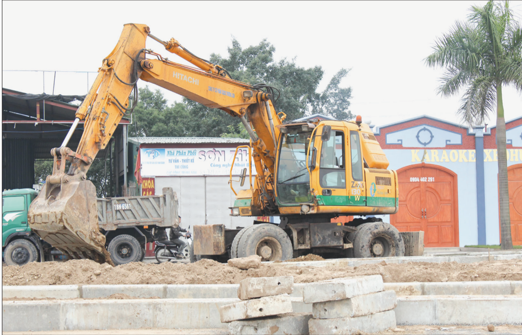
Thị công tuyến tránh thị trấn Đông Hưng (Đông Hưng).
