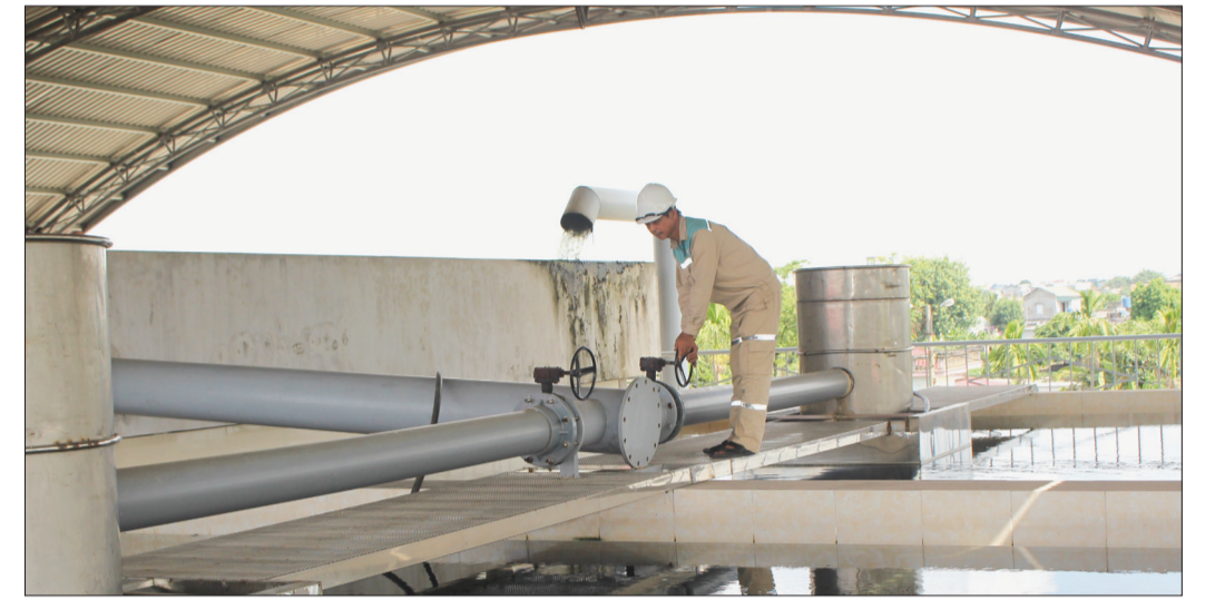
Công ty TNHH Đầu tư phát triển Thành Vinh (Đông Hưng) đầu tư nhà máy nước sạch Phong Châu từ nguồn vốn tín dụng của Agribank Chi nhánh huyện Đông Hưng, Bắc Thái Bình.
