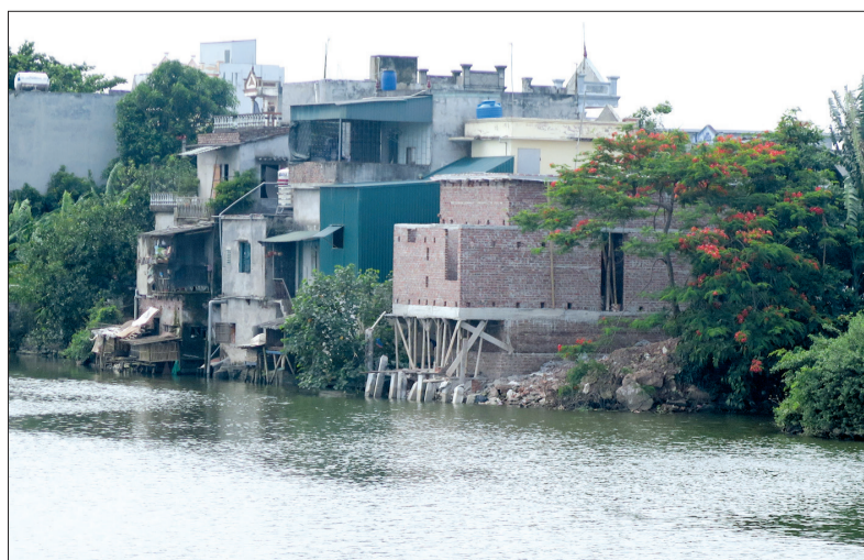
Một số hộ dân lấn chiếm xây nhà kiên cố trên sông Kiến Giang.
