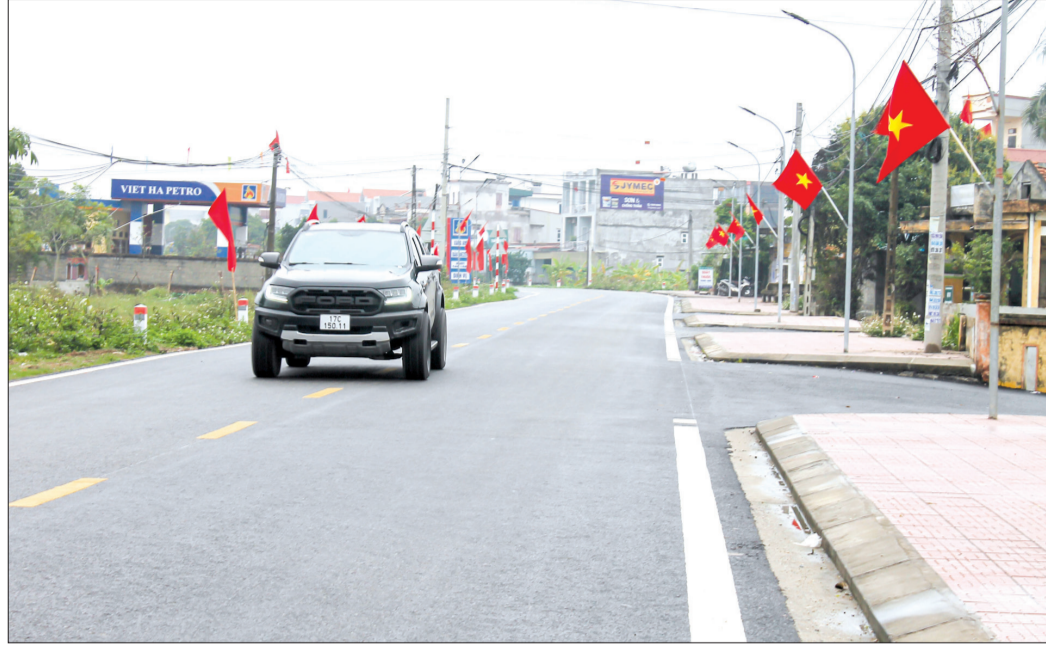
Tỉnh lộ 454 từ cầu Tịnh Xuyên đi thành phố Thái Bình khang trang nhờ sự đồng thuận, ủng hộ giải phóng mặt bằng của hàng trăm hộ dân hai bên đường.
