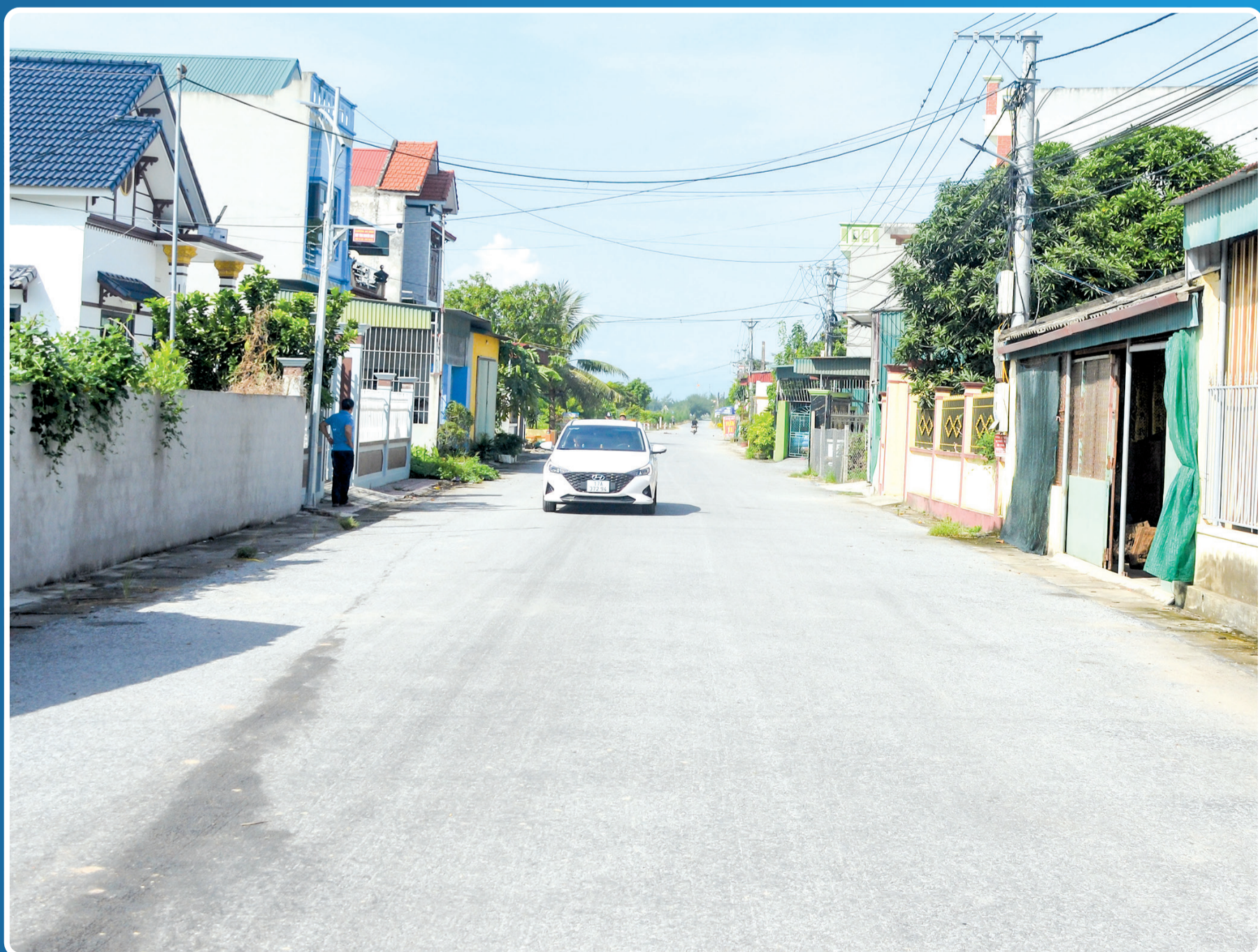
Tuyến đường từ xã Quỳnh Hội đi xã An Vinh được mở rộng 9m góp phần thúc đẩy kinh tế địa phương phát triển.
