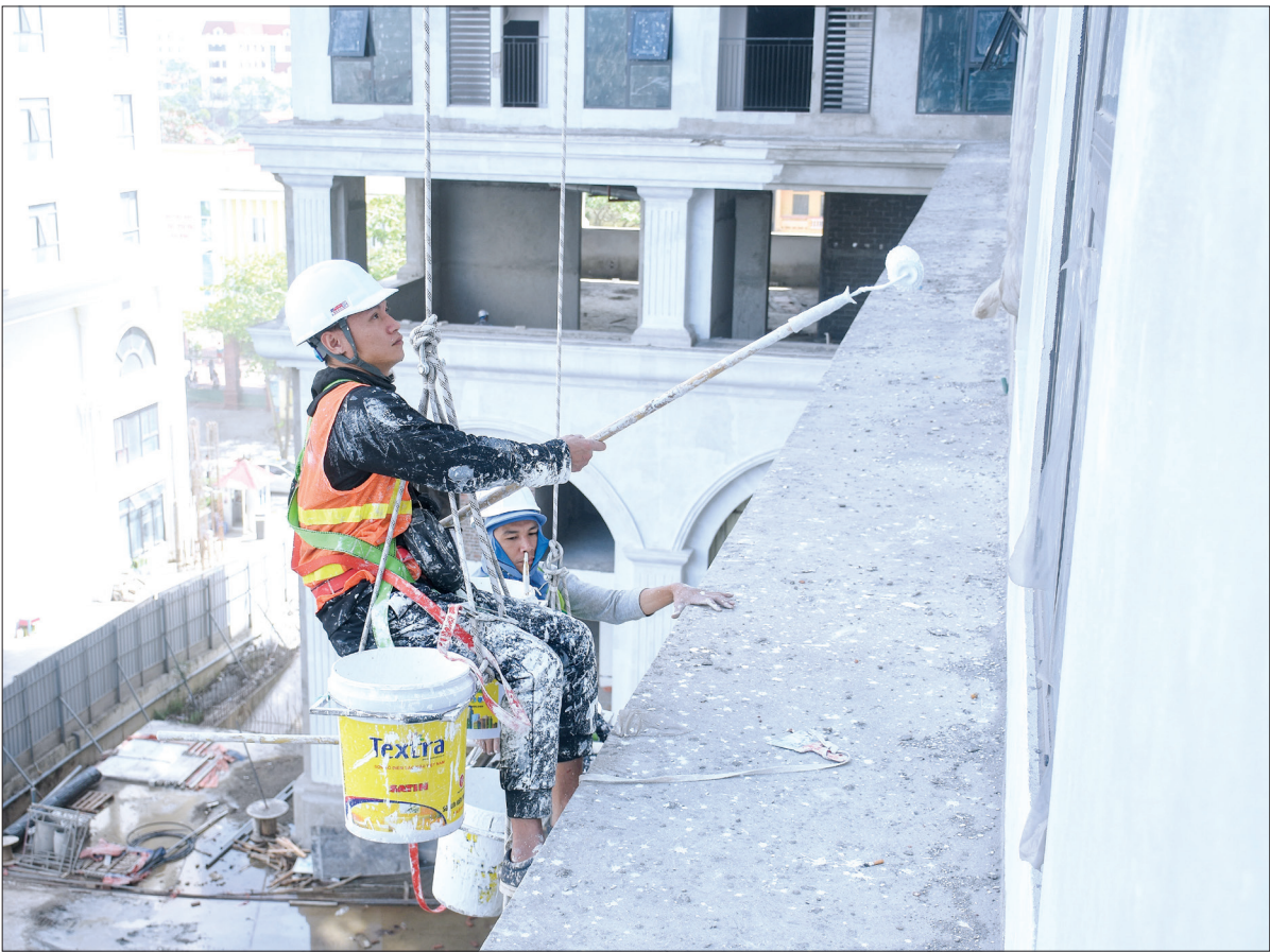
Giai đoạn sơn phía ngoài công trình xây dựng khu nhà ở thương mại tại phường Lê Hồng Phong (thành phố Thái Bình) đòi hỏi nghiêm ngặt về an toàn, vệ sinh lao động.
