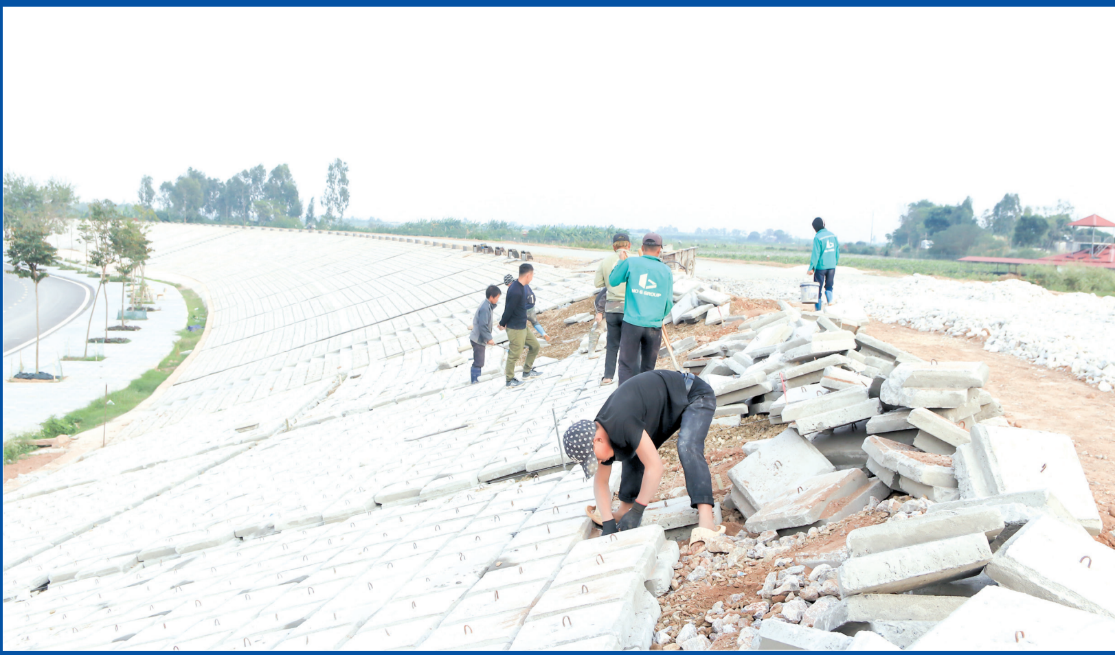
Thí công kè lát mái thượng lưu cầu Tịch Xuyên.
